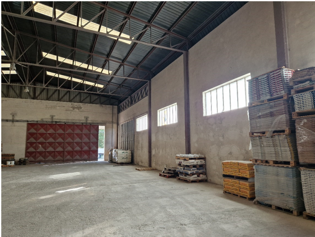
Foto 2 – Materiale accatastato all'interno dei capannoni
